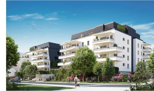
BATIMENT D - MONTEE 5 APPARTEMENT T3 N°5002 au Rez de jardin
